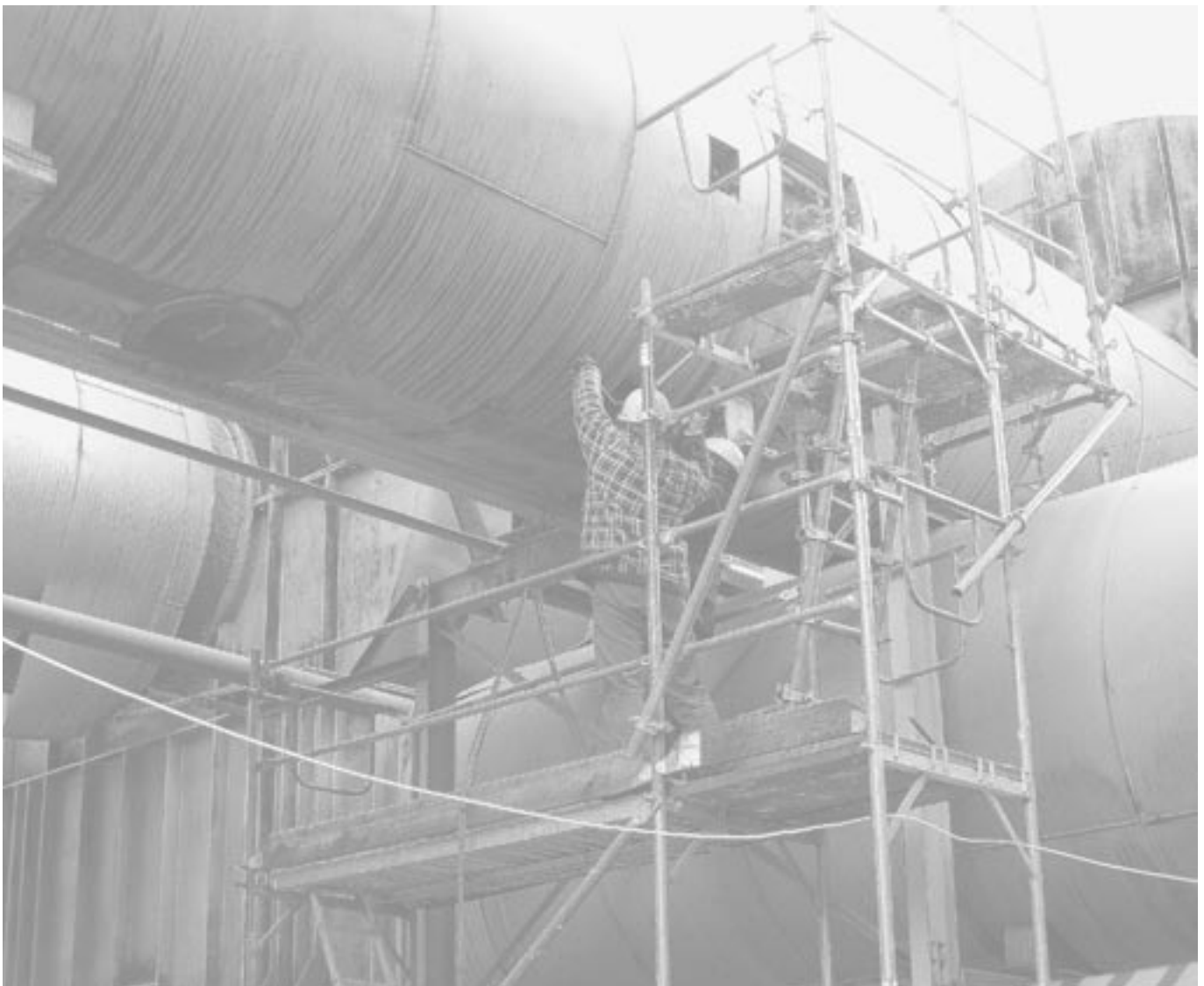
Vorschriftsmäßige Absicherung bei Wartungsarbeiten
